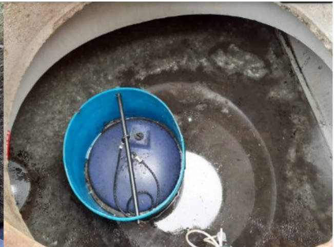
Etat d'un compartiment du séparateur d'hydrocarbure de l'installation. Présence d'une couche huileuse et d'irisations ainsi que d'une sorte de moisissures
