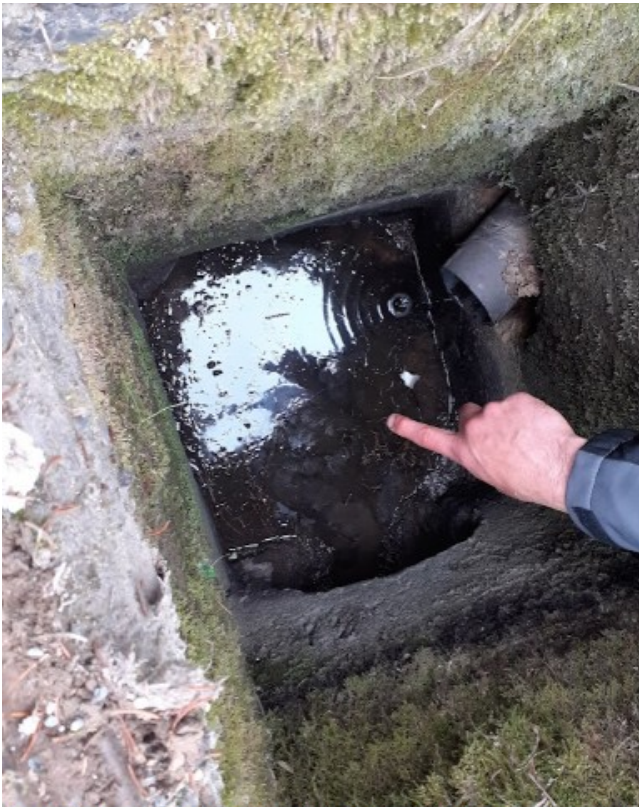
Au niveau du regard (puisard de collecte) de la ZA, présence d'irisations et de boues huileuses et d'hydrocarbures venant de la conduite en provenance du séparateur Recycl'Autos
