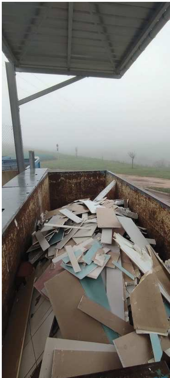
Benne couverte pour les déchets de plâtre (bonne pratique)
