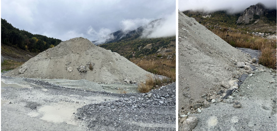
Stockage des cutting et boues de curage CAB (bâche présente)
