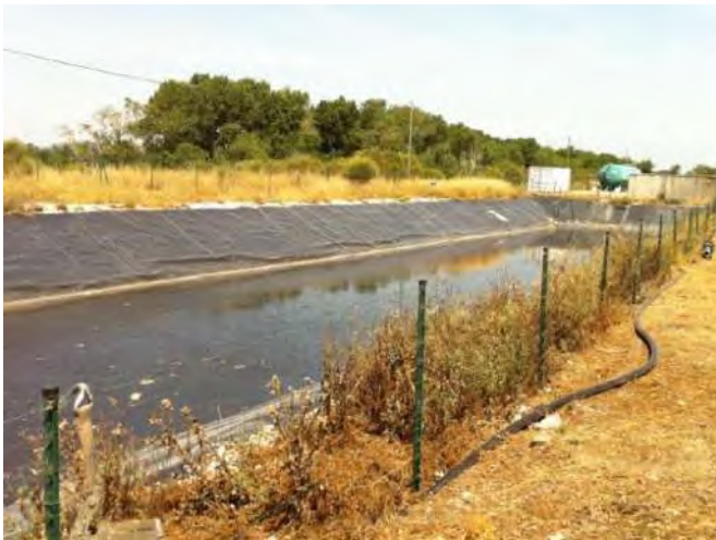
Figure 1-21 : Bassin de rétention
