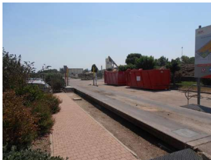
Figure 1-11 : Pont bascule de pesée réception/expédition
