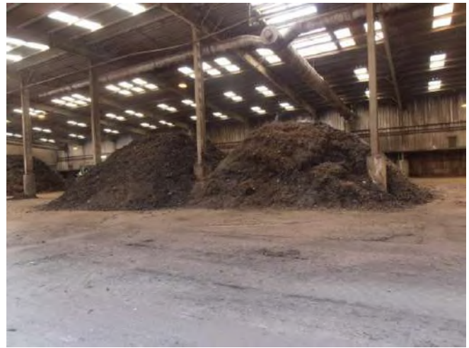
Zone de pré-maturation avant criblage
