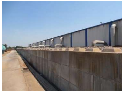
Figure 1-18 : Ventilateurs process et bio-filtre
