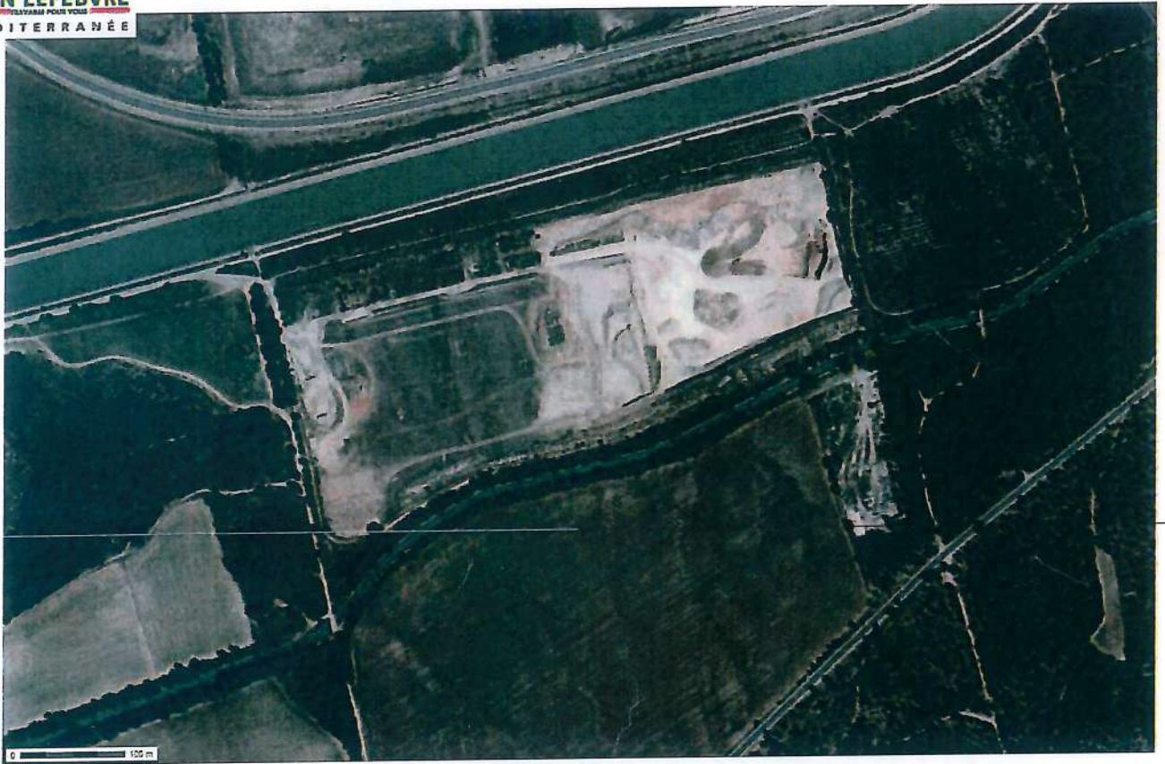
Photo 1 : Photo aérienne de l'état actuel du site
