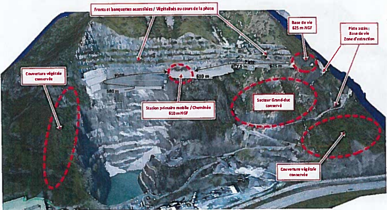
Figure 2 : SOCARL - Carrière du PIBESTE : Figure 2 Phase 1 (TO + 5 ans) / Exploitation - Remise en état coordonnée B . M . P . P . - Mars 2016
