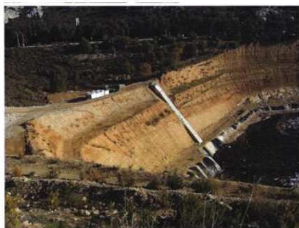
Figure 11 : Puits de captage des lixiviats du casier 3
