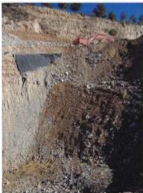
Figure 21 : Dépassement de la géomembrane par les déchets stockés (03 février 2005)
