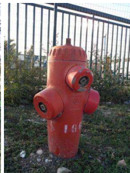
Poteau externe Sud n°166
