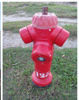
Poteau externe Nord n°125
