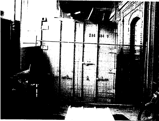
Unité de dépollution à l'arrêt
