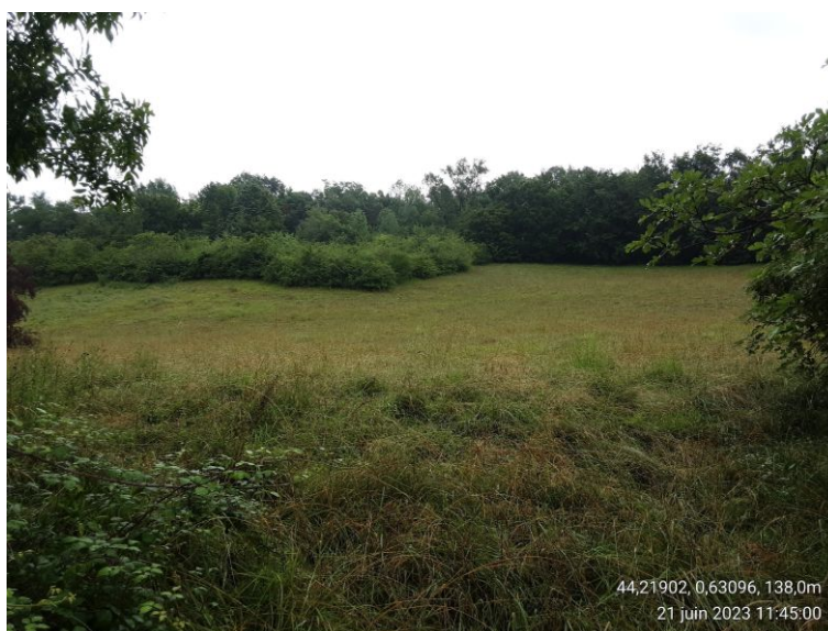
Figure 10: Coteau est bordant la partie sud de la combe de Payou. Des indices de déformations sont visibles.
