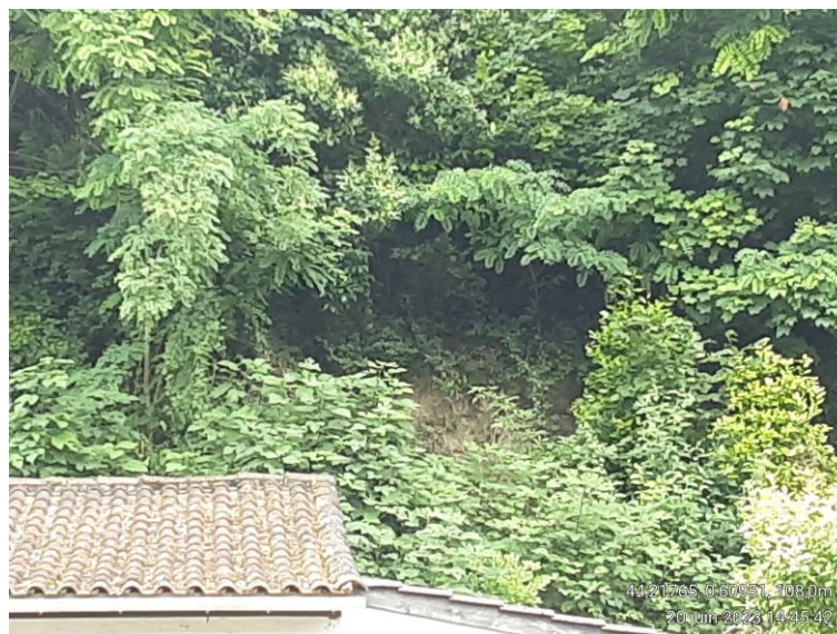
Figure 6: Trace de glissement superficiel (décimétrique à métrique) sur un escarpement en bordure de l'Avenue de Vérone.
