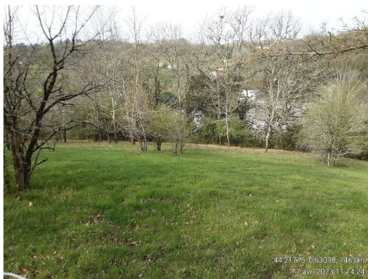
Figure 11: Pentes situées en contrebas de la rue des Deux Rocs et montrant des déformations.
