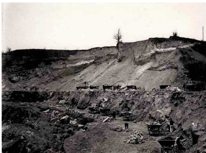
Figure 8: Photographie d'une carrière de calcaire grossier exploitée à ciel ouvert, sur le versant de la vallée de la Bièvre à Arcueil (source : archives de l'IGC)
