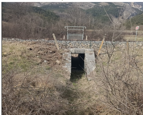
Pertuis présent sous la voie ferrée permettant le franchissement d'une partie des éventuels écoulements débordants de la voie ferrée
