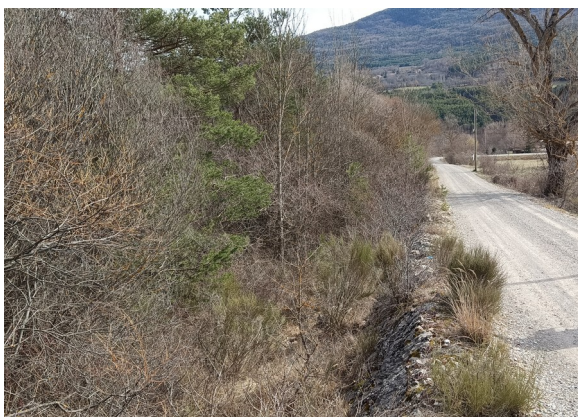
Route digue présente en rive droite du torrent
