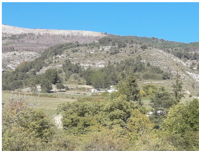
Versant exposé à des chutes de pierres, source ONF-RTM
