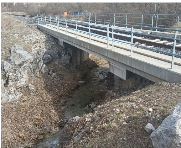
Pont de la voie ferrée de gabarit important
