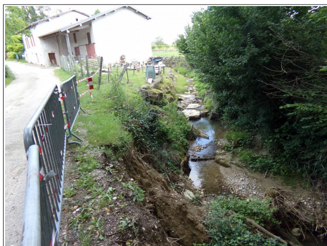
Figure 1: érosion de berge le long du ruisseau du Gardon dans le hameau de Mollon (commune de Villieu-Loyes-Mollon)
