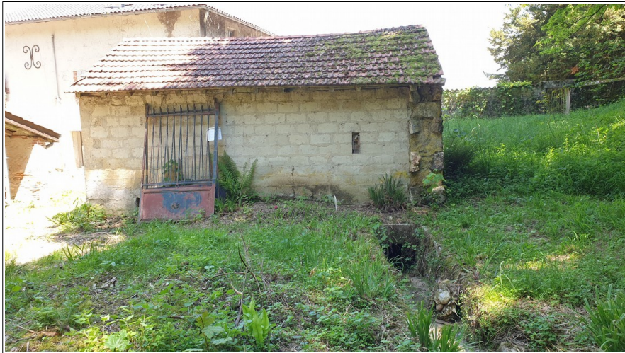
Figure 4: ruisseau du Château de Boissieu busé à l'amont du village de Varambon.
