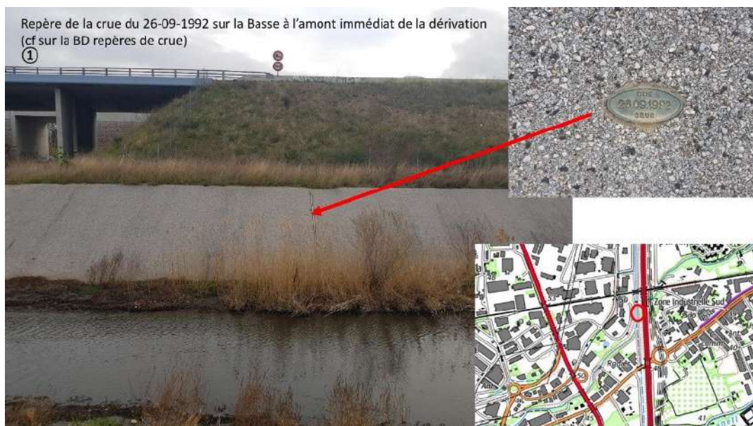
Illustration 27 : Repère de crue de 1992 sur la Basse (source Ville de Perpignan)
