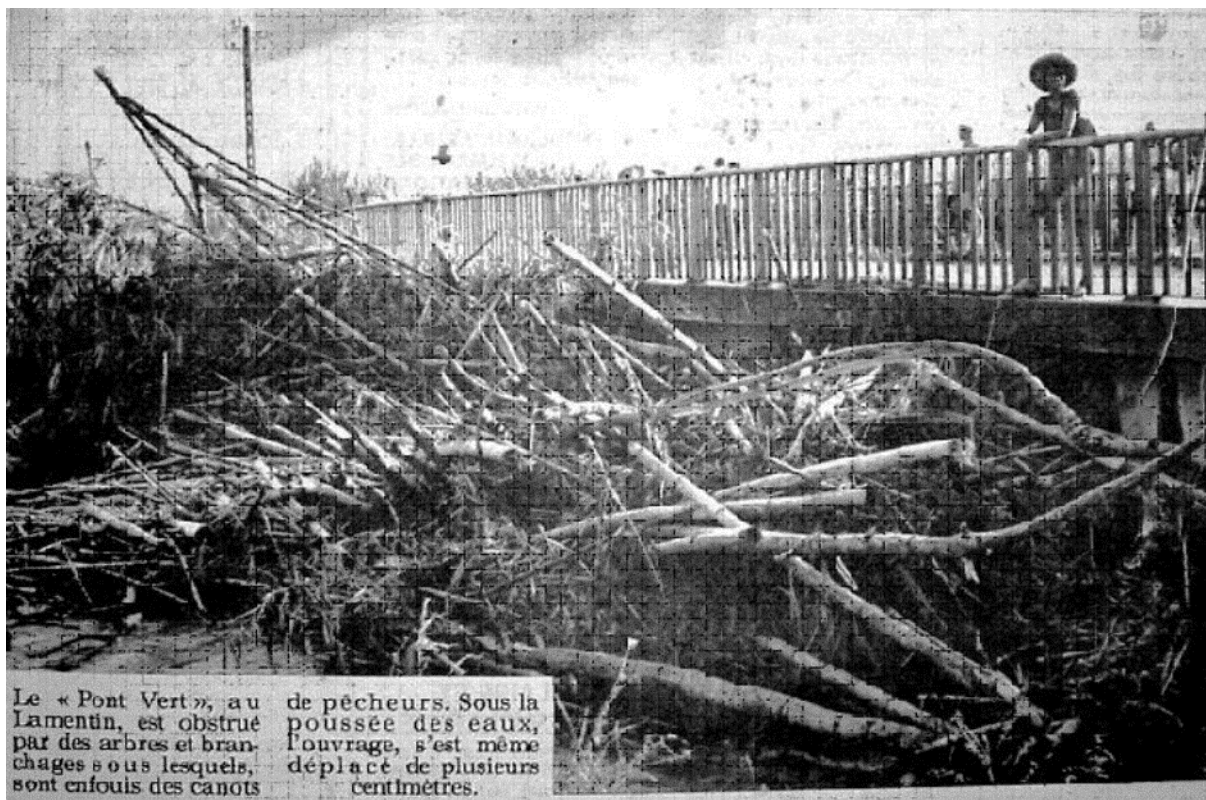
Figure 10 : Embâcle au niveau du Pont-Vert au Lamentin (en novembre 1966) [Source : France-Antilles]
