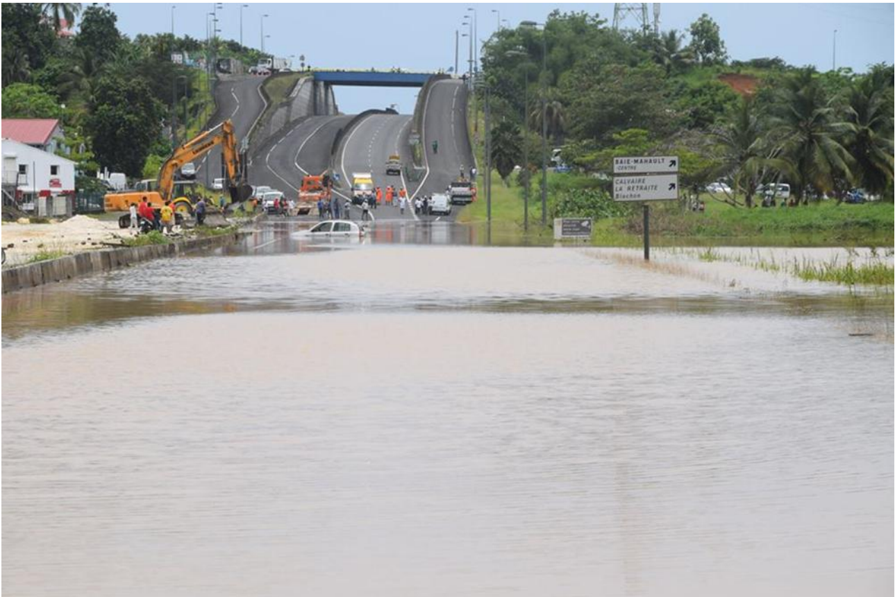
Figure 6 : Inondation de la RN2 à la hauteur de l'échangeur de Beausoleil à Baie Mahault par débordement de cours d'eau (en mai 2017) [Source : Alain Hannibal Canal 10 Télévision/97Land]
