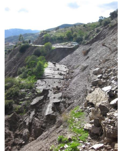
Figure 16 : Schéma conceptuel du phénomène de glissement de terrain (à droite) et glissement en bordure de l'Oued Nekor, au Maroc (à gauche) [Source : IMSRN]
