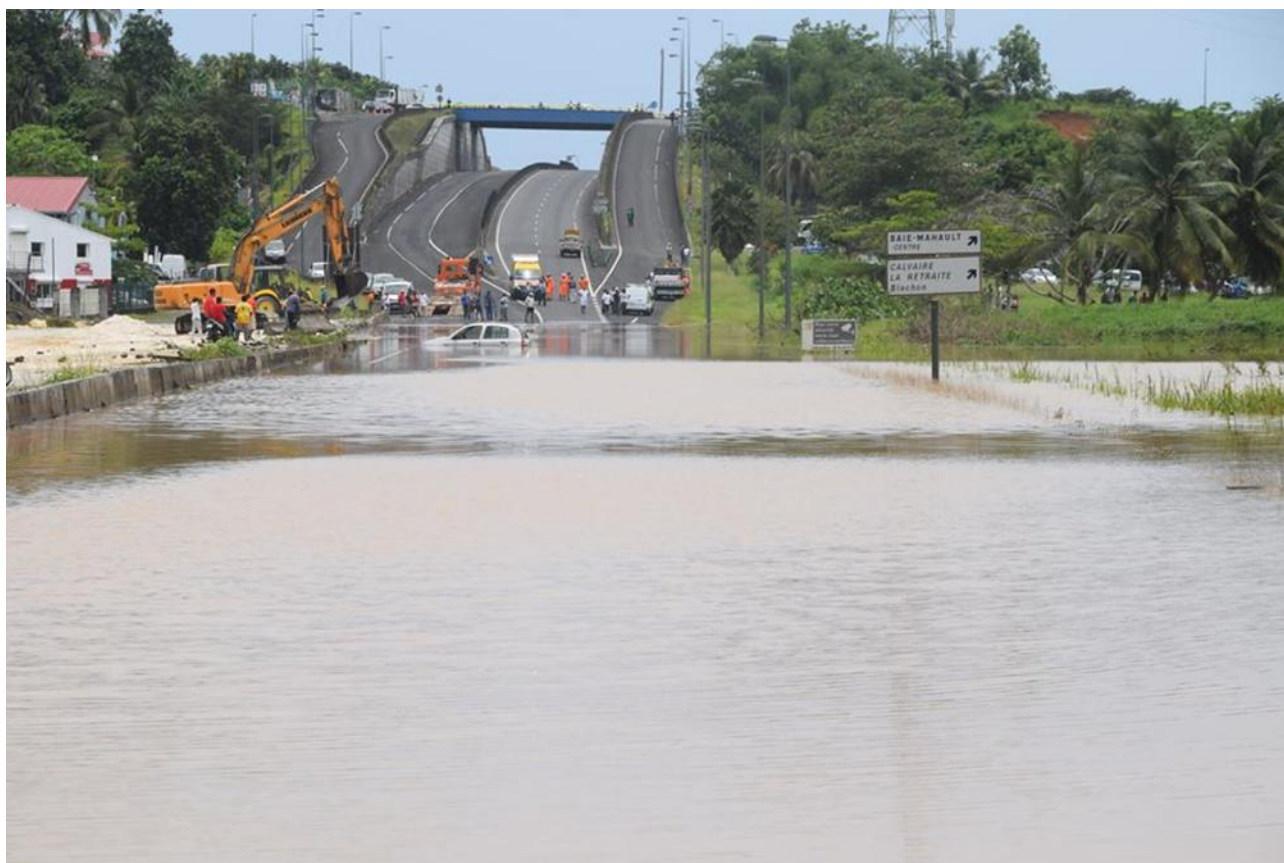
Figure 6 : Inondation de la RN2 à la hauteur de l'échangeur de Beausoleil à Baie Mahault par débordement de cours d'eau (en mai 2017) [Source : Alain Hannibal Canal 10 Télévision/97Land]
