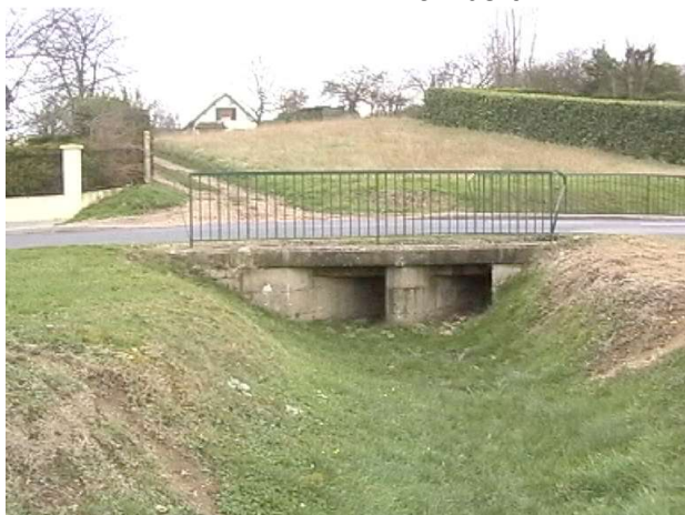
OH 2 - pont au croisement rue du tilleul - place de Villambert
