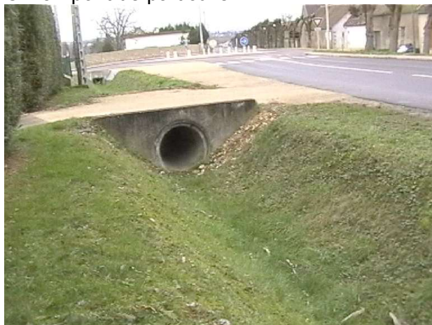
OH 5 - pont de particulier
