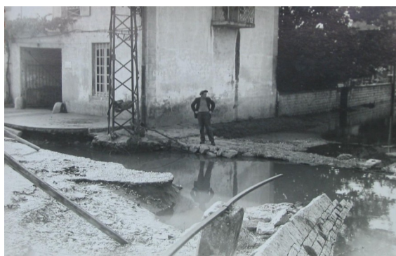
Rue de Bram après crue 1935
