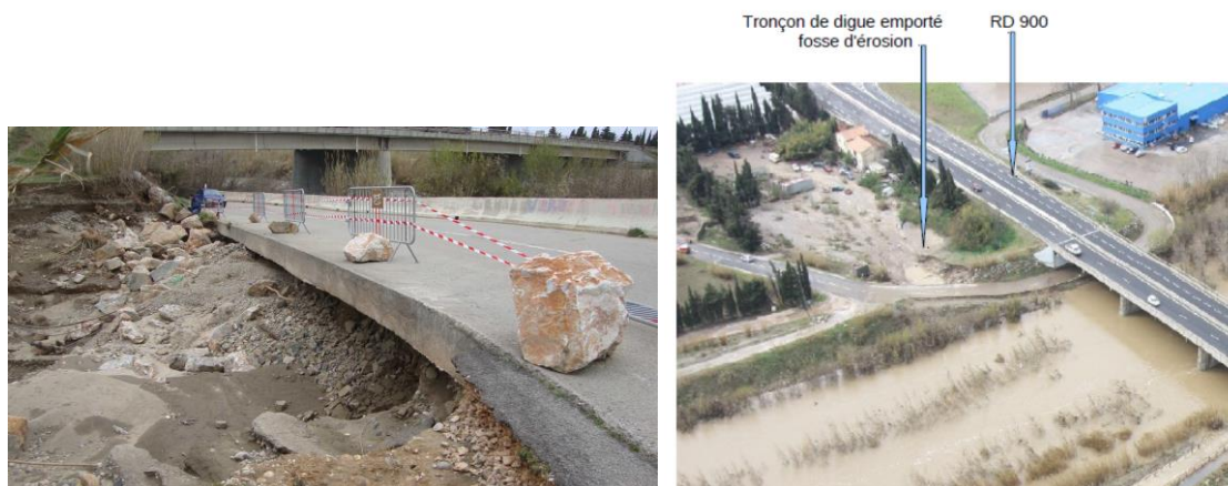
Brèche en rive droite à l'aval immédiat de la RD900 – Mars 2013
