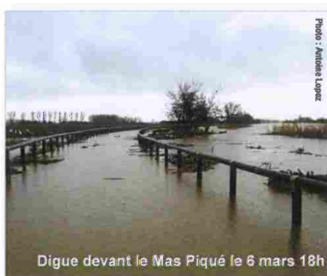
Crue du 6 mars 2013 – Digue rive gauche à Clair – Mas Piqué (surverse sans brèche)
