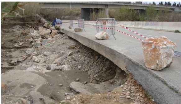
Brèche en rive droite à l'aval immédiat de la RD900 – Mars 2013
