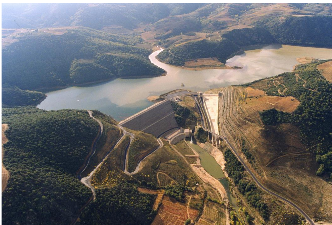
Vue du barrage sur l'Agly
