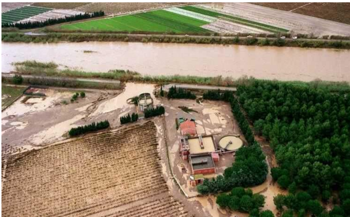
Brèche à la station d'épuration de Saint-Laurent de la Salanque (rive gauche) – crue de 1999
