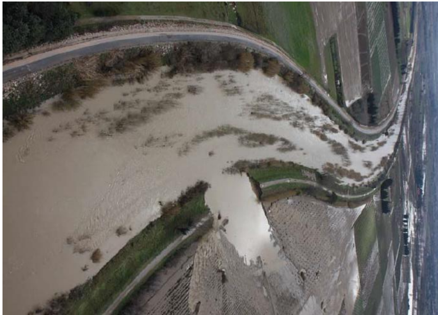
Brèche de Pia en rive droite – Mars 2013
