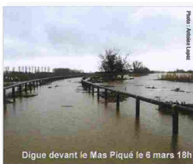
Crue du 6 mars 2013 – Digue rive gauche à Clairà – Mas Piqué (surverse sans brèche)
