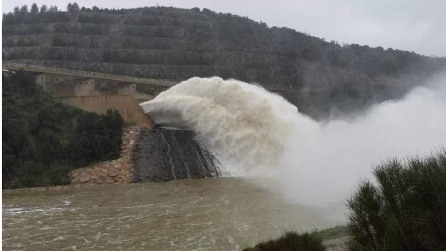
Barrage sur l'Agly le 22 janvier 2020 vers 14 heures
