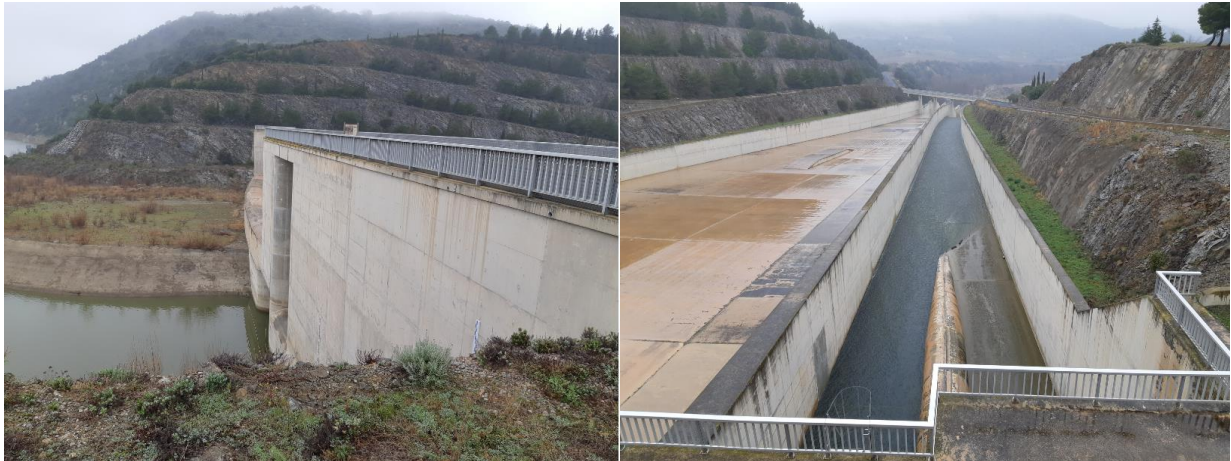
Vues du barrage de l'Agly (barrage de Caramany) – déversoirs de crue
