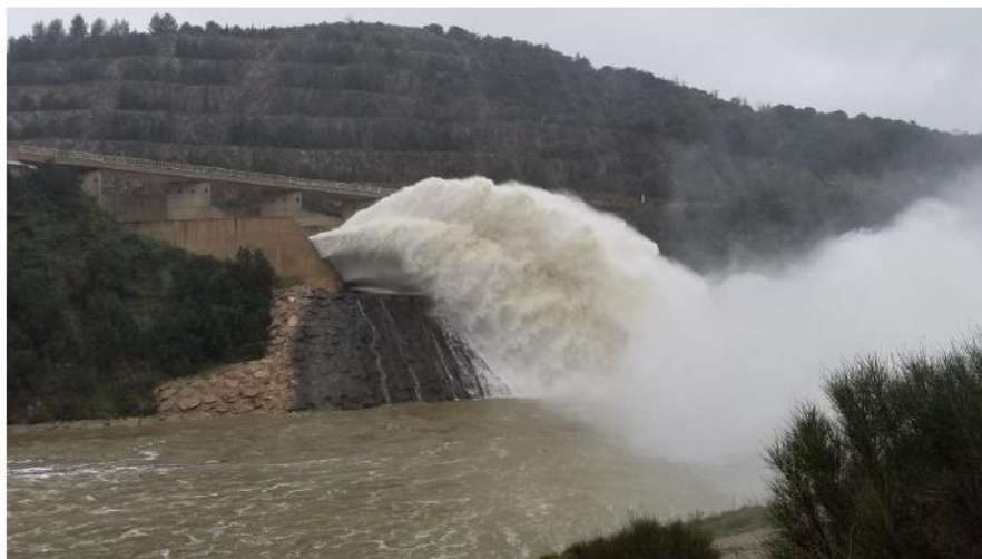
Barrage sur l'Agly le 22 janvier 2020 vers 14 heures
