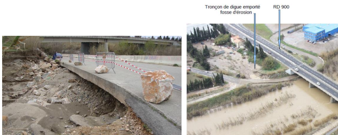
Brèche en rive droite à l'aval immédiat de la RD900 – Mars 2013
