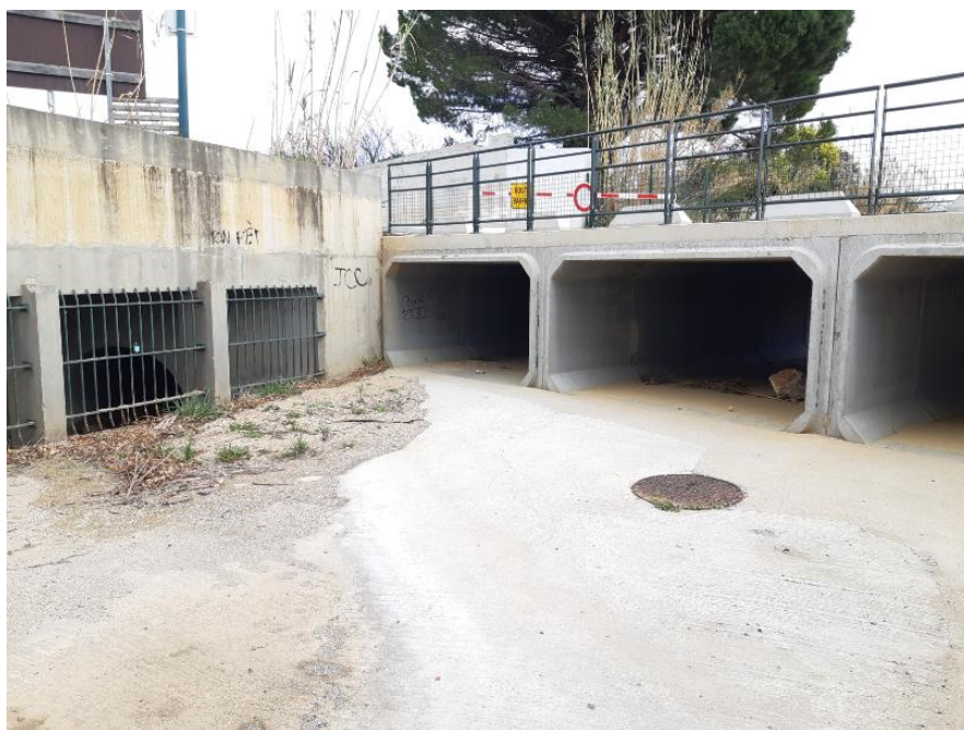
La « Llobère » (Ravin des Oms) au droit du passage à gué Zac des Jardin (by-pass à gauche sur la photo vers le ravin des Avens)
