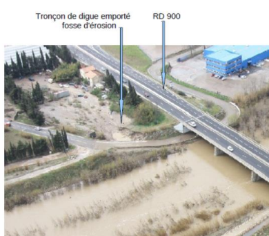
Exemples de ruptures de digues lors de la crue de 2013 (Aval RD900 en rive droite en bas à gauche - Pia en haut et en bas à droite)
