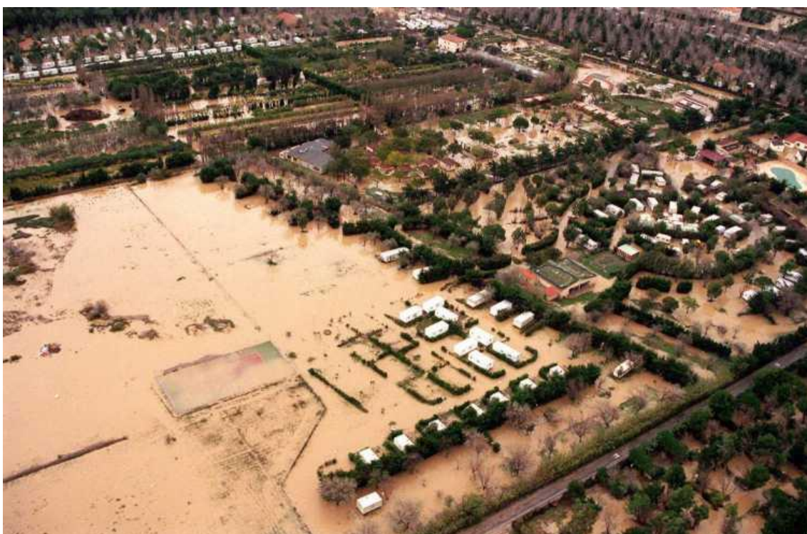
Camping Le Barcarès inondé – crue de 1999
