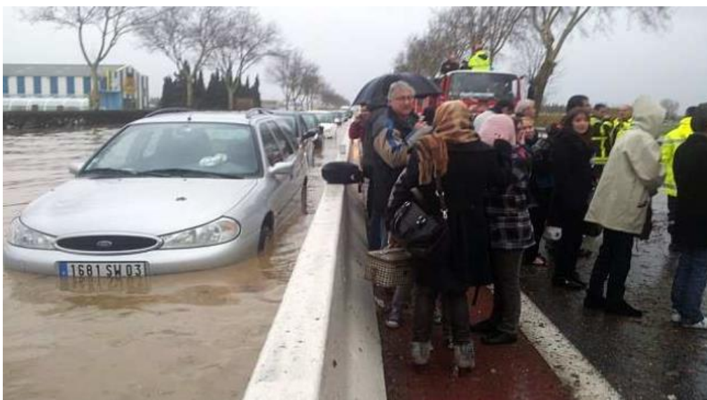
Crue de mars 2013 illustrant l'inondation de la RD900 avec sa Glissière en Béton Armée (GBA). Source : France 3 - Languedoc-Roussillon.
