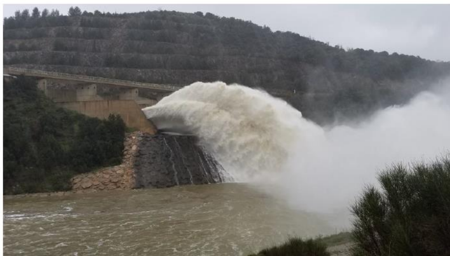
Barrage sur l'Agly le 22 janvier 2020 vers 14 heures
