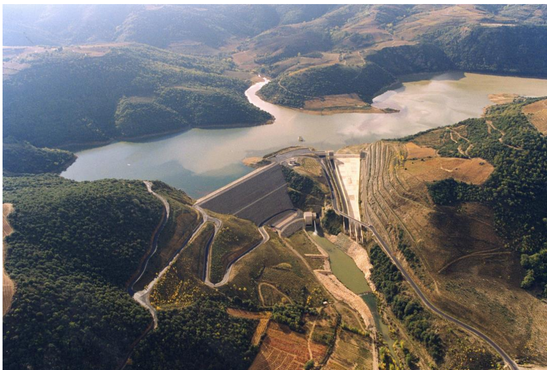
Vue du barrage sur l'Agly
