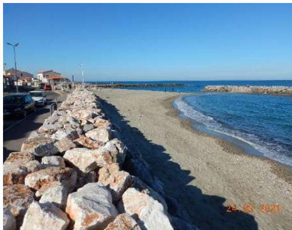
Illustration 25 : Enrochements au Nord du port de Sainte-Marie
