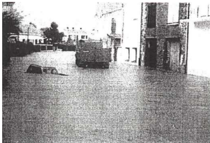
Illustration 31 : Inondation du boulevard des Corbières à Villelongue-de-la-Salanque en 1986 (Source Mairie de Villelongue de la Salanque)
