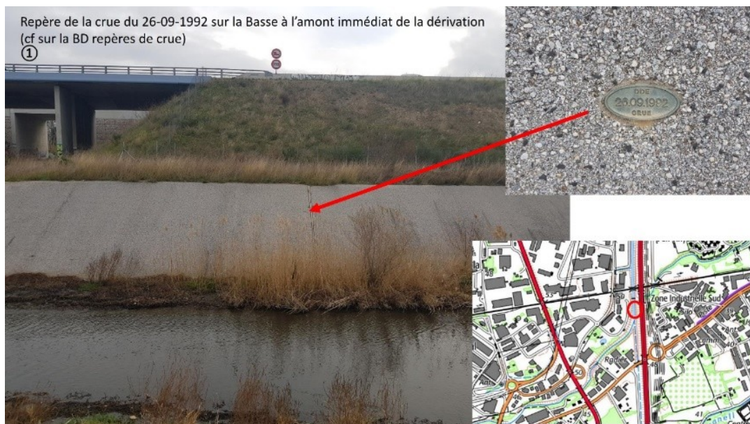
Illustration 22 : Repère de crue de 1992 sur la Basse (source Ville de Perpignan)
