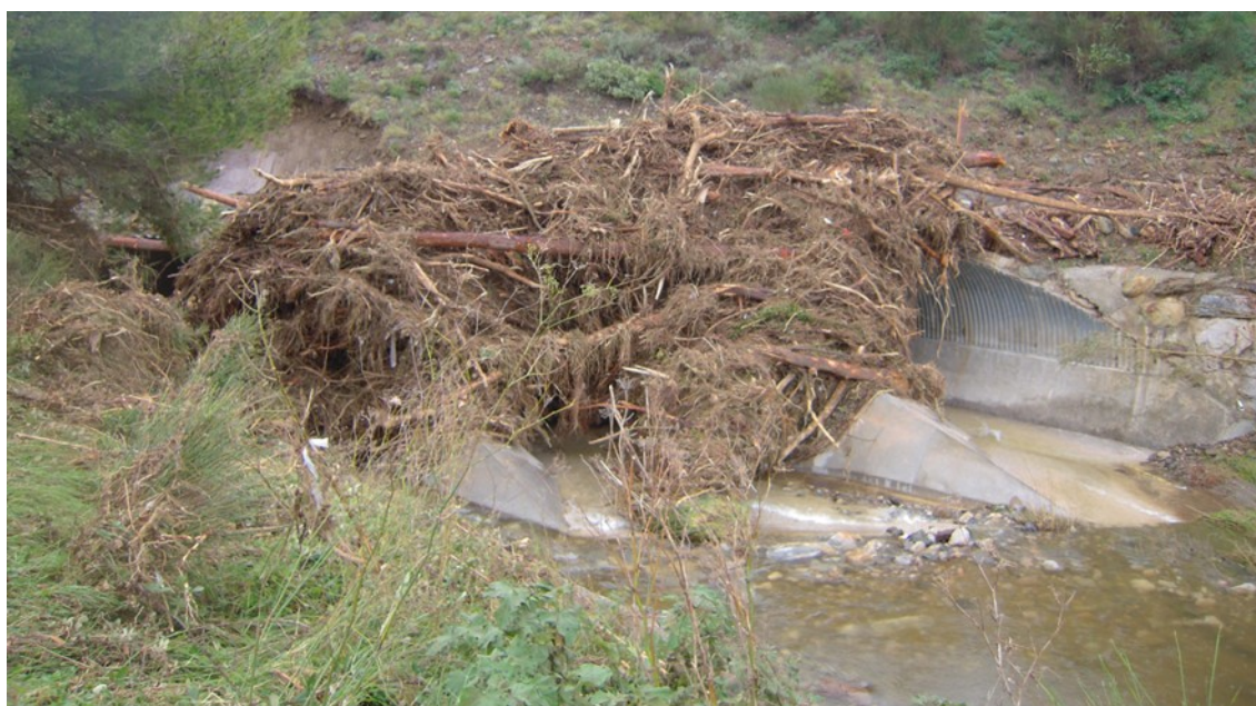
Illustration 9 : Buses sur le ravin Le Ravaner - commune d'Argelès sur mer sous la RD 914 - novembre 2014
