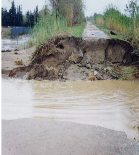
Illustration 5 : Brèche sur l'Agly à Saint-Laurent de la Salanque lors de la crue 1999 (photo DDTM66)
