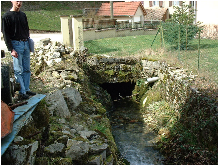
Amont du franchissement de la voie communale
