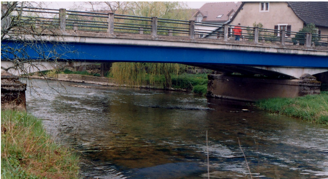
Pont de Grandvillars
