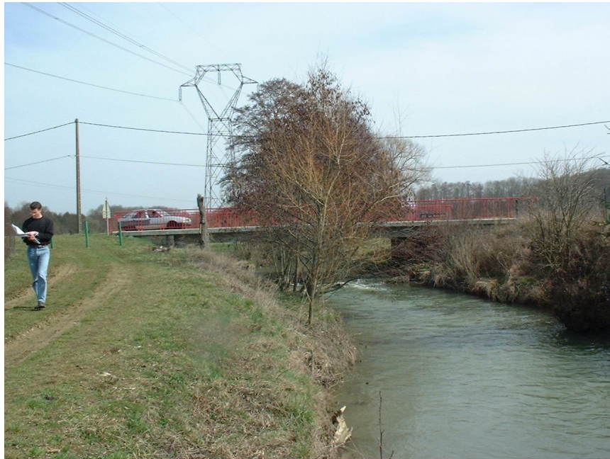
Pont sur la RD26 à Faverois
