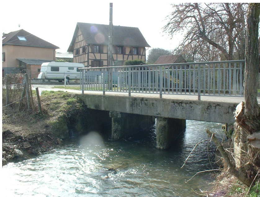
Ouvrage aval dans le bourg
