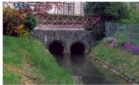
Franchissement du canal par la RD23
