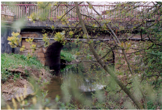
Pont de la RD23 sur le bras mineur
