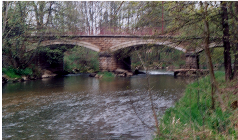
Pont de la RD23 sur le bras principal
