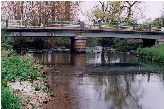
Pont de la RD44 à THIANCOURT
