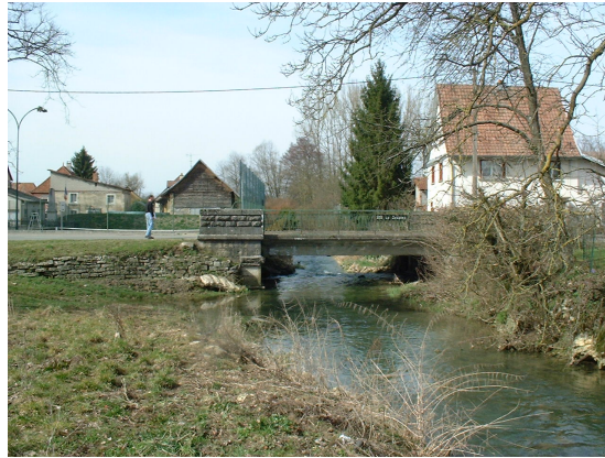
Franchissement amont de la Coeuvatte
