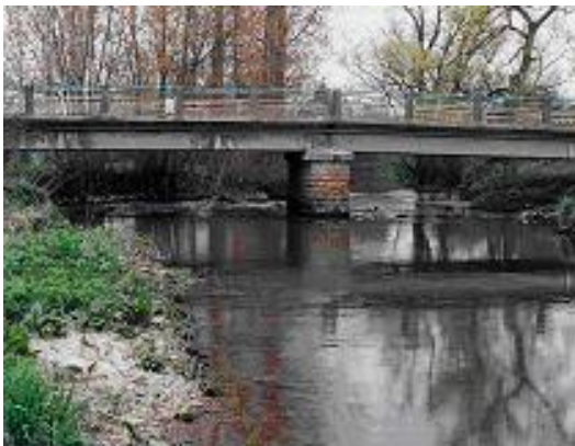
Pont de la RD44 à JONCHEREY
