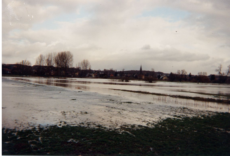
Crue de 1994 - Vue du lit majeur en amont de la RD44 (village de JONCHEREY en fond)
