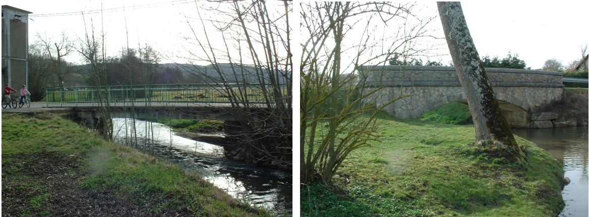
Les deux ponts franchissant la Vendeline à Courtelevant
