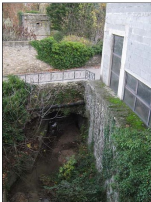
Le Pied de Baix en aval de la voie SNCF
