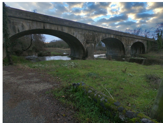
Figure 2: Pont de la RD86
