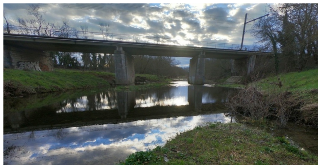
Figure 4: Pont de la voie ferrée
