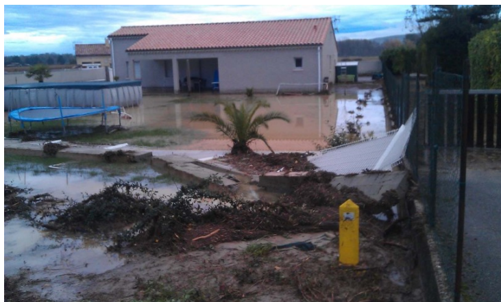
Dégâts de la crue du 14-15 novembre 2014 - Chemin de Panaillau
