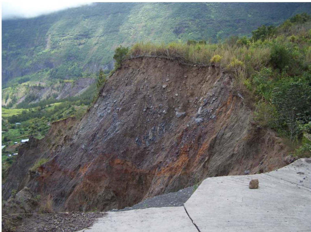
Figure 23 : Recul d'une dizaine de mètres du versant en bordure Est d'Ilet à Vidot suite à Gamède. Cet événement a emporté une partie du chemin menant à un élevage porcin.
