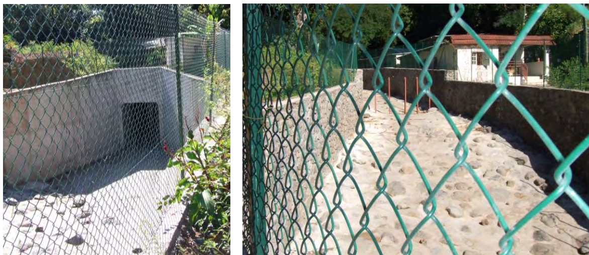
Figure 34 : à gauche, dalot reprenant les eaux de la Ravine Duparc au niveau de la Montée des Veuves ; à droite, aménagement de la ravine en amont de l'entrée du dalot de la Montée des Veuves
