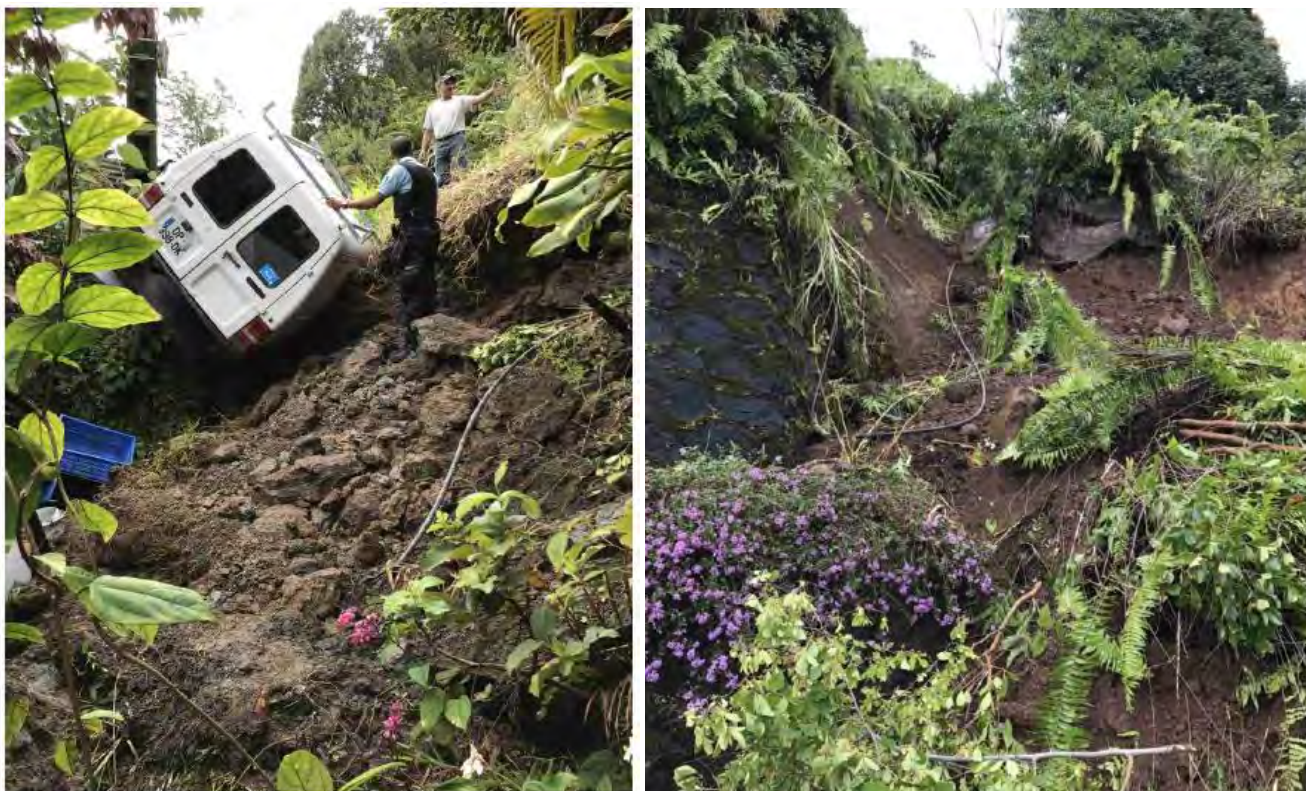
Figure 24 : Glissement de terrain d'un volume estimé à 1000 m 3 survenu Chemin Bras Sec le 20 aout 2017
