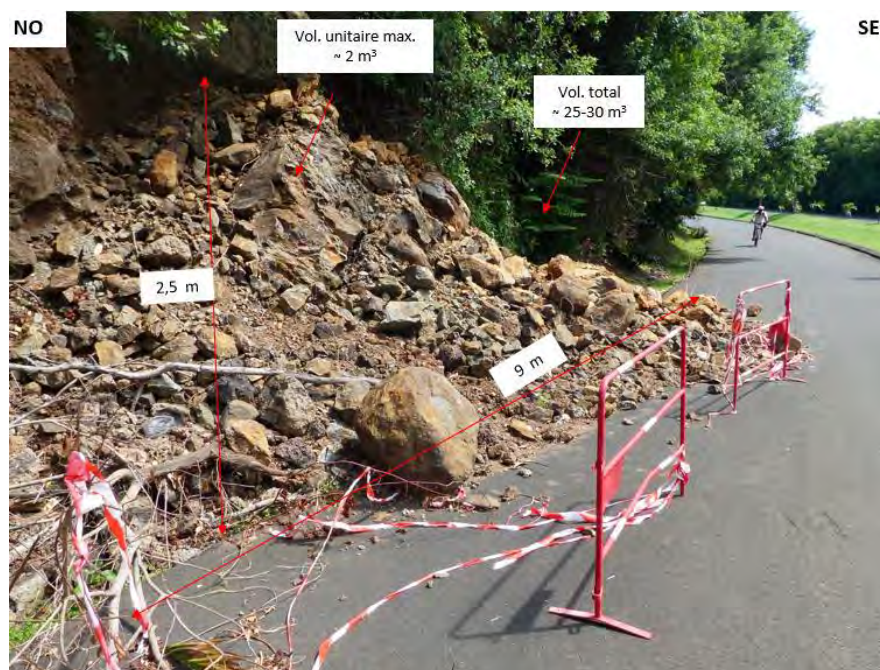
Figure 21 : Éboulement rocheux au niveau du talus rocheux dominant le sentier littoral survenu le 04/01/2018
