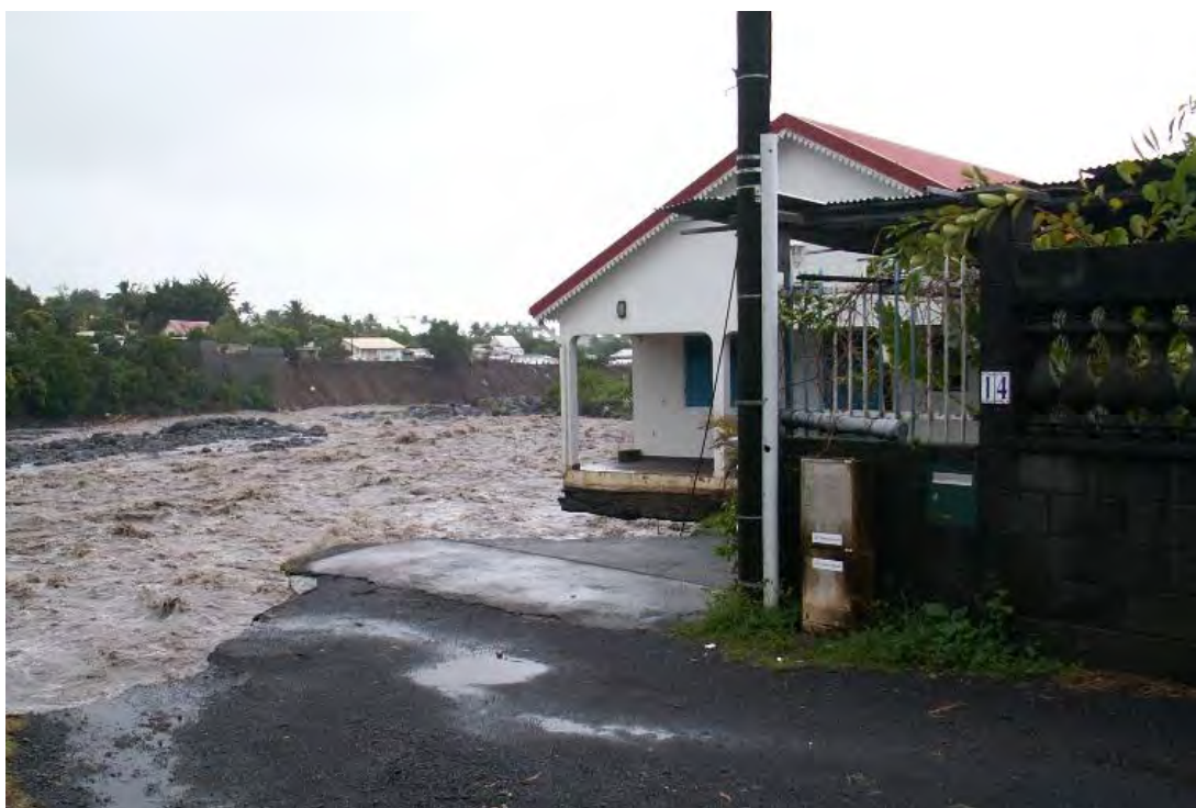
Figure 26 : Forte érosion de berges suite aux crues de la Rivière des Pluies de 2006 (tempête Diwa)
