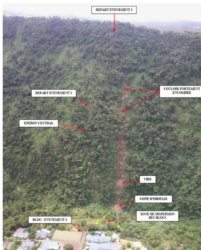
Figure 25 : Chutes de blocs dans le secteur de la Passerelle en 2014
