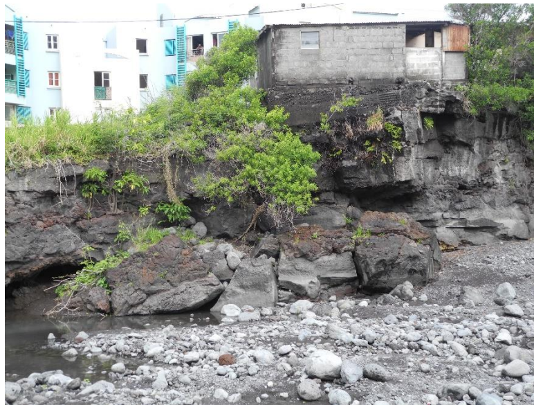
Figure 14 : Coulée de lave très récente de Saint-Joseph, en rive droite de la rivière des Remparts
