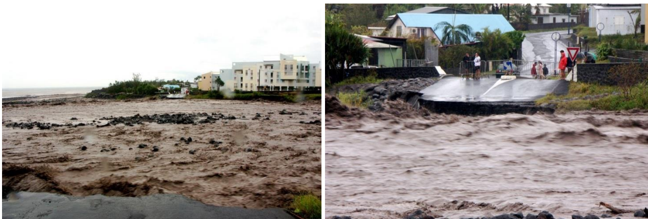
Figure 34 : Crue de la Rivière des Remparts pendant le cyclone Gamède (2007)
