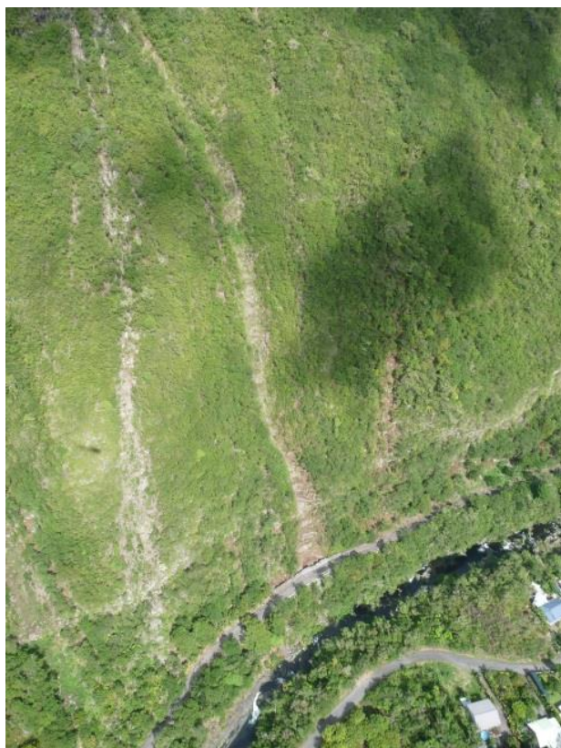
Figure 24 : Couloir de propagation des blocs au niveau du secteur de la Passerelle – Route d'accès à Grand Galet – événements de 2010 et 2011
