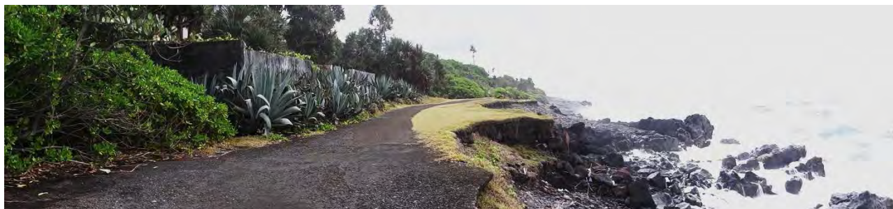
Figure 25 – Erosion au Nord de la jetée du Butor (photographie BRGM, 2013)
