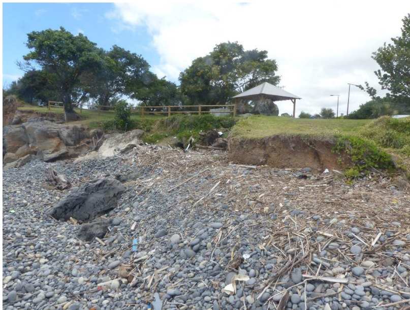
Figure 24 : Erosion récente du talus en haut de cordon de galet proche du centre-ville de Sainte-Marie et du quartier des Cocotiers (Campagne OBSCOT, 2018)
