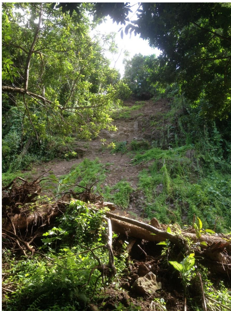
Figure 11 : Eboulement en rive droite de la Rivière des Marsouins vu depuis le Chemin Danclas (source : rapport BRGM/RP-65693-FR)
