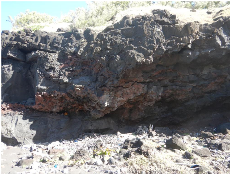
Figure 22 : Sous-cavage liée à l'action répétée des vagues sur le pied de falaise, risque d'effondrement accru (BRGM, 2020)
