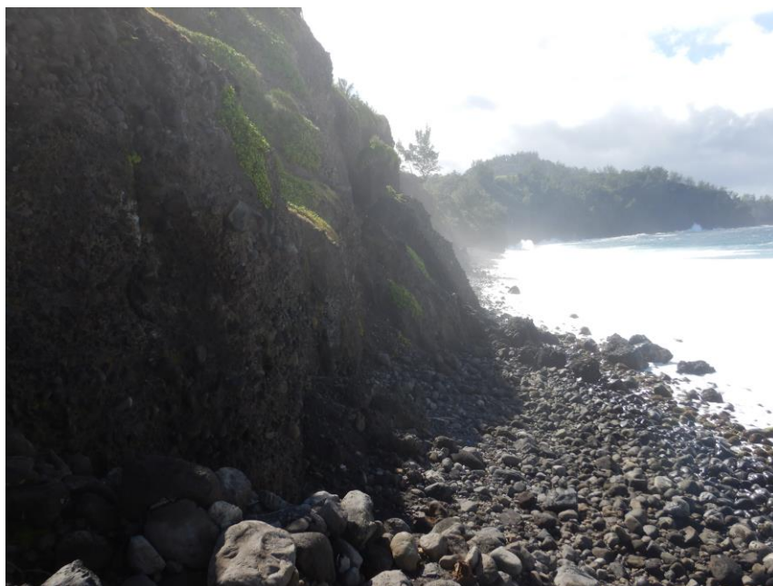
Figure 7 : Falaise meuble en érosion, la paroi présente des décrochements (BRGM, 2020)
