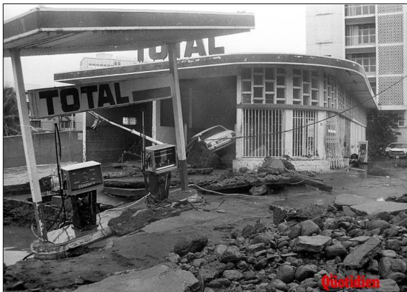
Figure 36 : Diavagations torrentielles de la ravine du Butor dans le secteur de Château-Morange, lors de Clothilda (1987) – cliché le Quotidien
