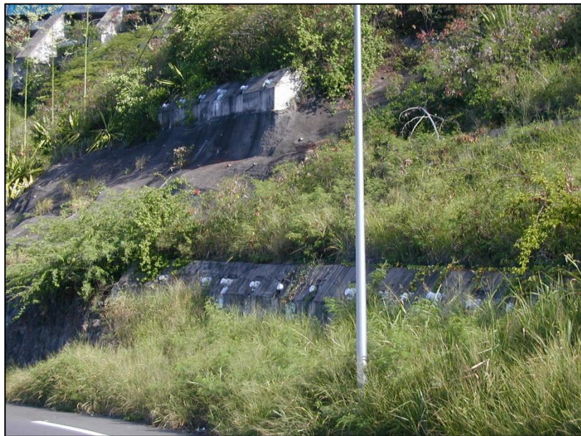
Figure 20 : Confortement du versant entre l'U2 et le début des rampes de la RD41
