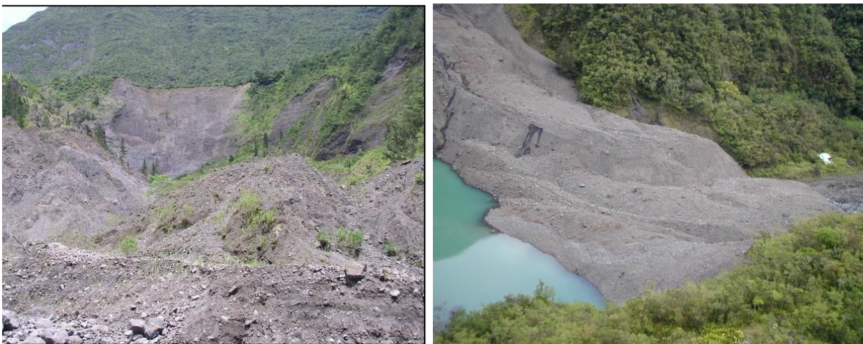
Figure 24 : "Grand éboulis" en 2002 dans le bassin amont de la Rivière des Pluies avec formation d'une retenue d'eau
