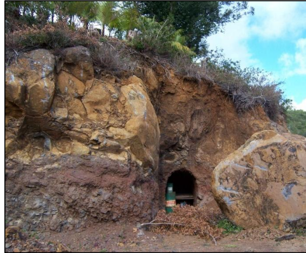
Figure 14 : Exemple de blocs potentiellement instables dans un versant assez fortement redressé - secteur de La Bretagne
