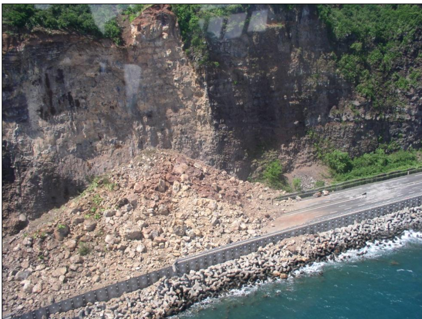
Figure 17 : Photographie de l'éboulement du 24 mars 2006 sur la Route du Littoral
