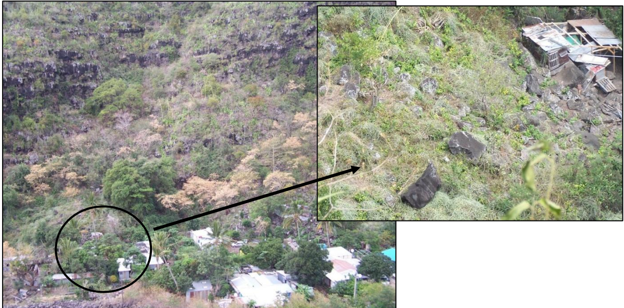
Figure 11 : Versant Est de la Grand Chaloupe - blocs éboulés en pied de paroi, à proximité d'une zone habitée
