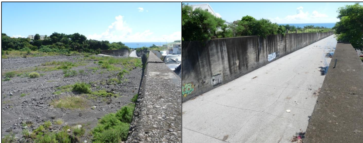
Figure 35 : Plage de dépôt et endiguement de la Ravine Patates à Durand, réalisés après yacinte
