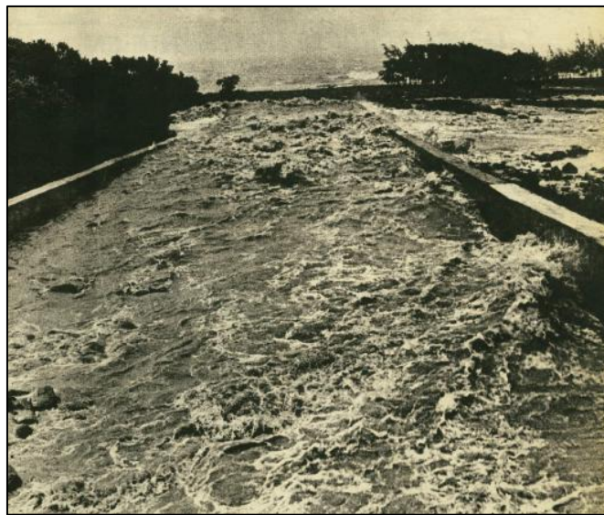
Figure 33 : Ravine Patates à Durand – Brèche et divagations torrentielles survenues lors du cyclone Hyacinthe (1980)
