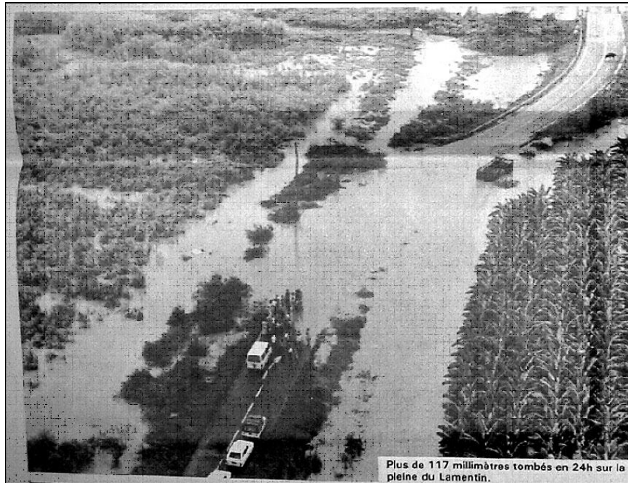
Figure 34 : Inondation par débordement des cours d'eau au Lamentin (en novembre 1984) [Source : France-Antilles]
