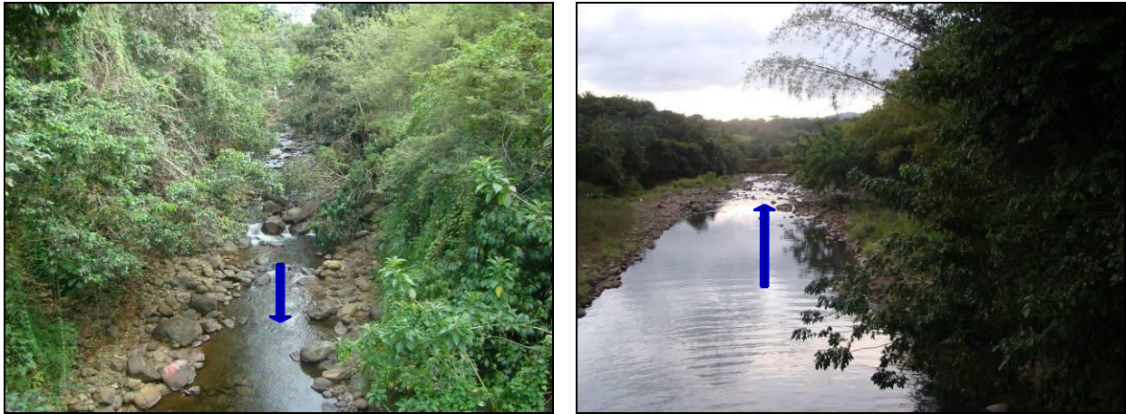
Figure 58 : Grande Rivière à Goyaves au pont de la RD 23 (à gauche) et au pont de Prise d'Eau (à droite) [Source : IMS RN ]
