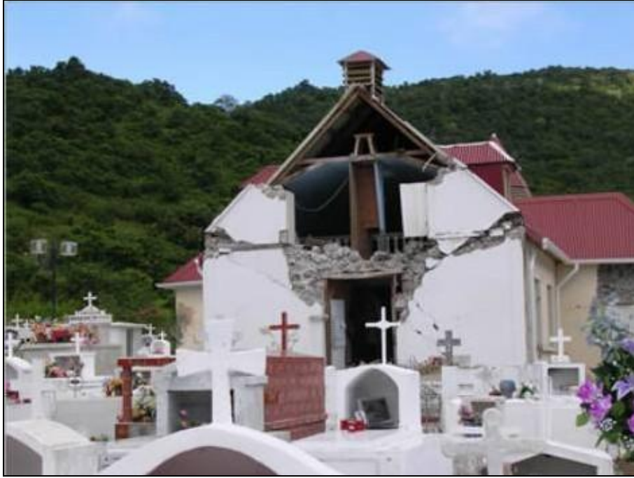
Figure 85 : Dommmages sur l'église du bourg de Petites-Anses, commune de Terre-de-Bas (Ile des Saintes) [Source : BCSF]
