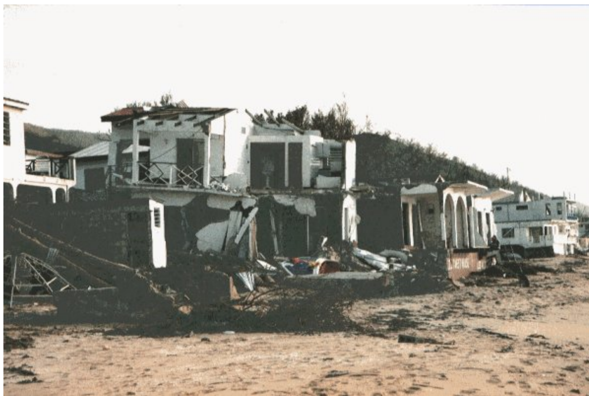
Photo 7 : Exemple de désordres observés après déferlement des houles cycloniques
