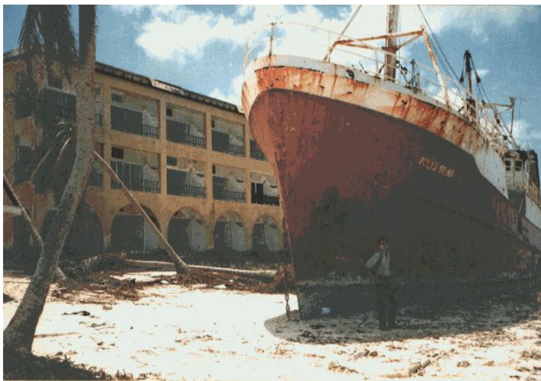
Photo 6 : Exemple de désordre lié aux marées de tempête
