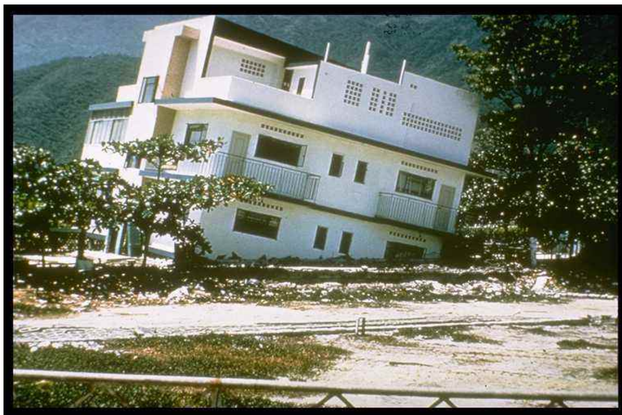
Photo 1 : Exemple des effets dommageables causés par la liquéfaction
