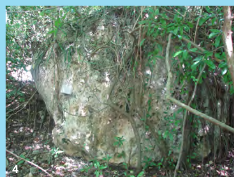
4 Éboulement en masse dont gros blocs (env. 10 m3)
