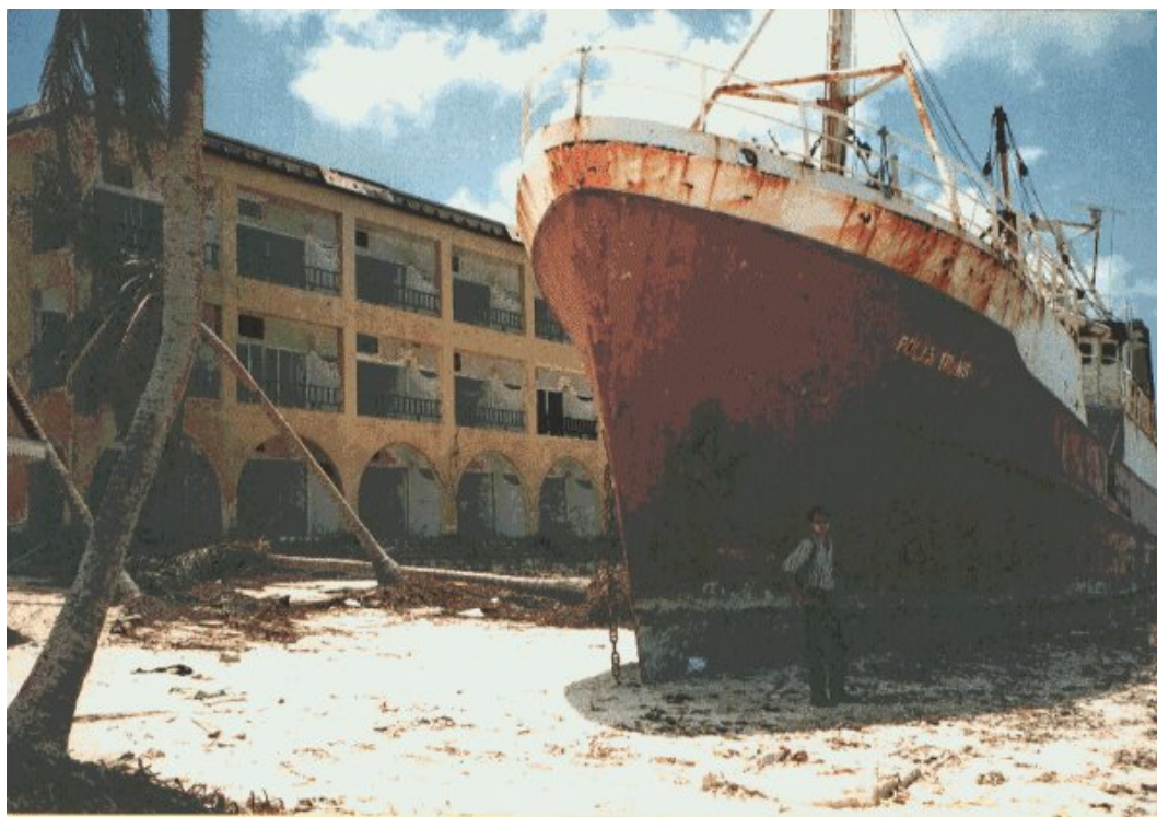
Photo 9 : Exemple de désordre lié aux marées de tempête
