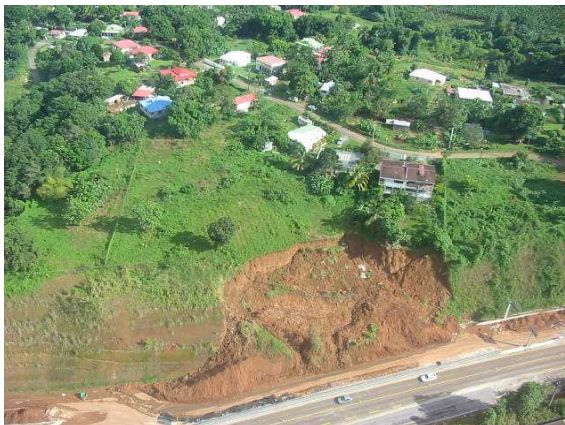
Vue sur le glissement de terrain de la RN 1 en novembre 2004 sur la commune de Petit Bourg.
